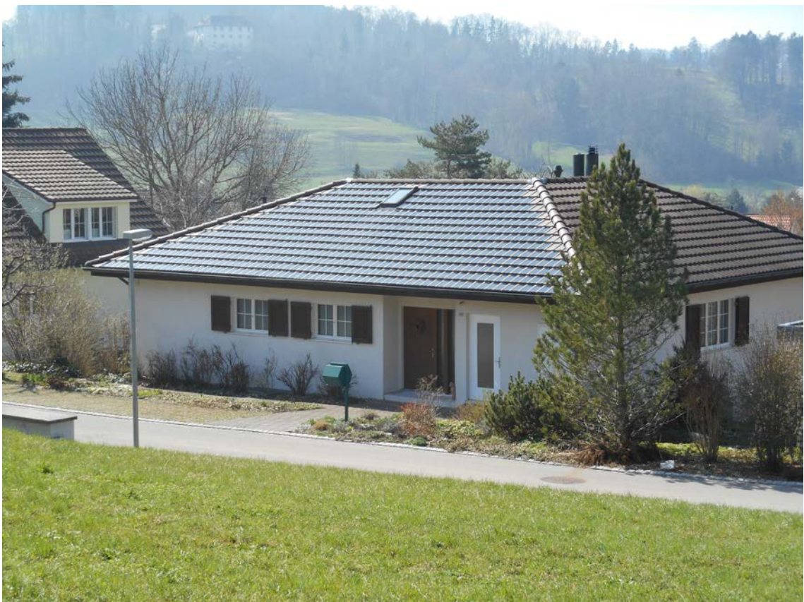
PV-Anlage an der Winzerstrasse in Elgg mit Panotron Solarziegeln.
